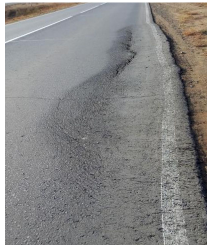
Рисунок 4 - Состояние контрольного участка с применением бокситного шлама КМ 32 -КМ 31+840 на автомобильной дороге «Павлодар-Успенка - гр. РФ»
