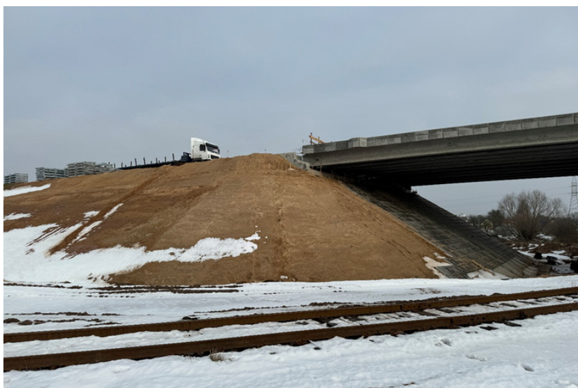
Рисунок 10 – Откос насыпи из армированного грунта на подходе к путепроводу
