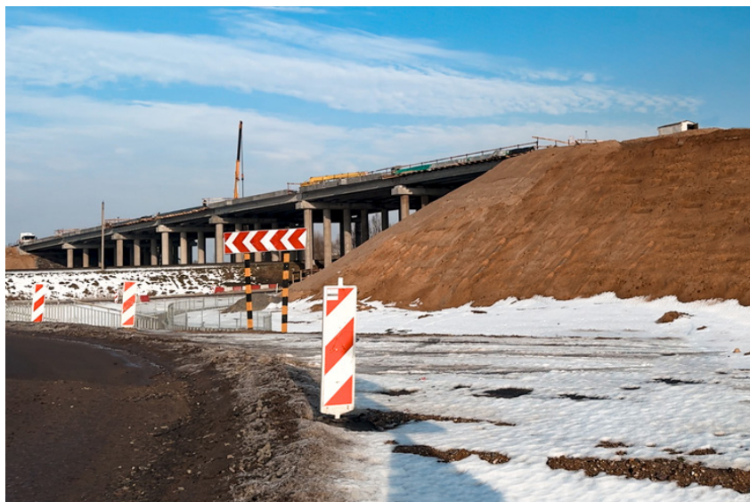
Рисунок 9 – Армированный откос и строящийся путепровод
