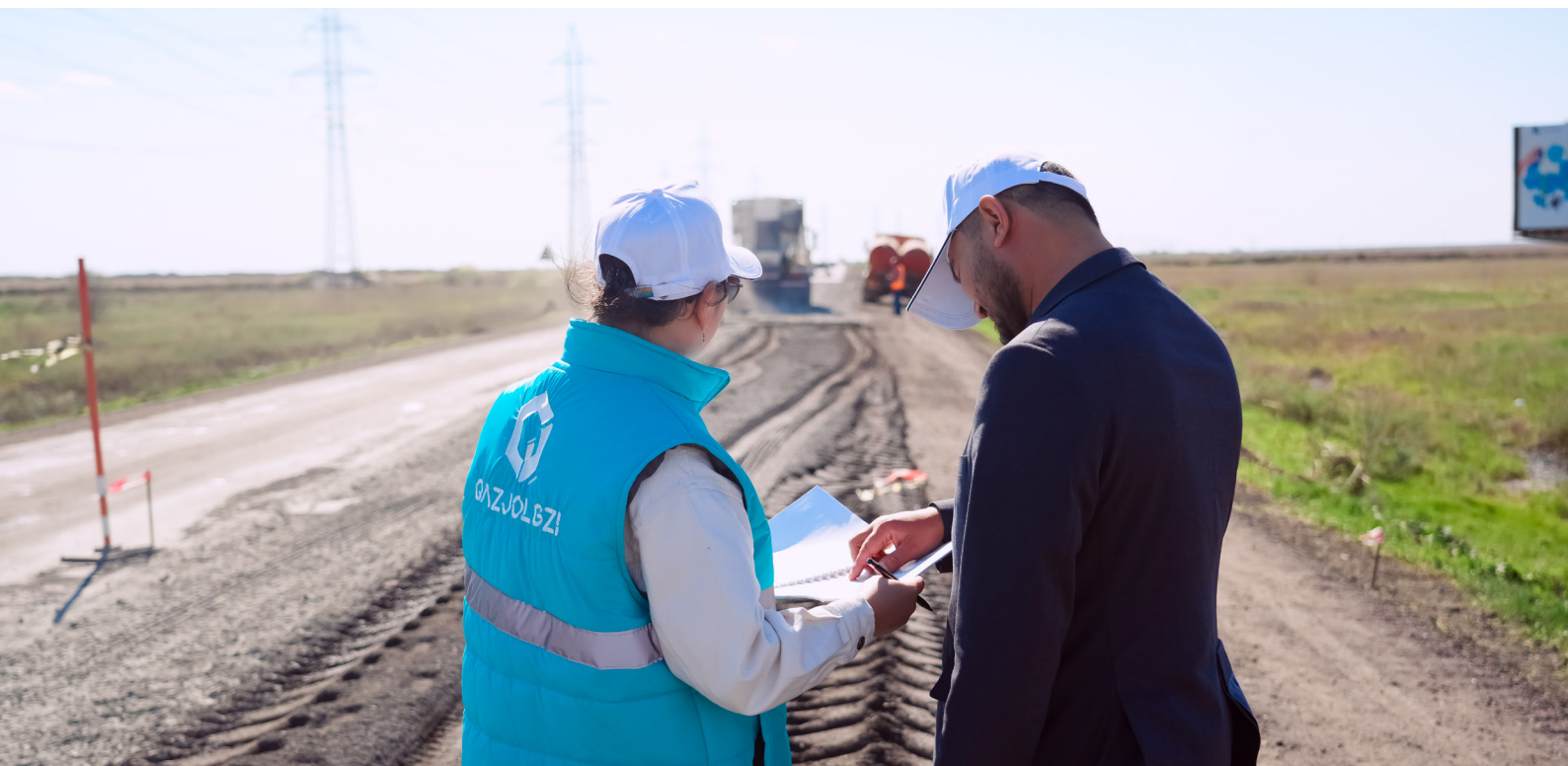
Участок автомобильной дороги Р-2 «Астана-Коргалжин»
