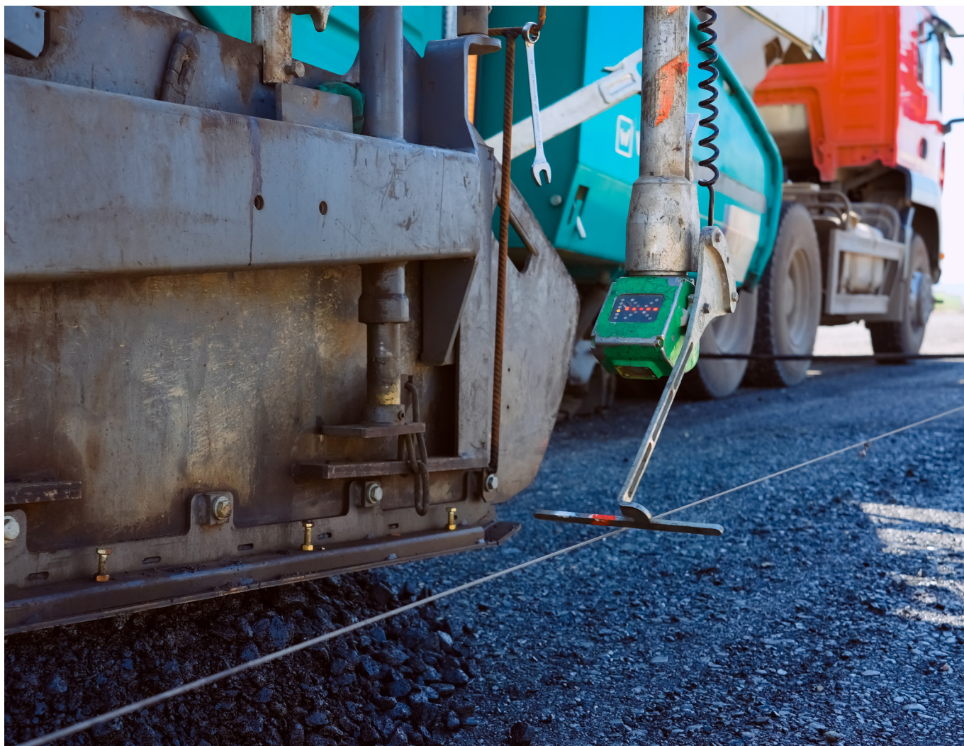
Участок автомобильной дороги «Узынагаш - Отар»
