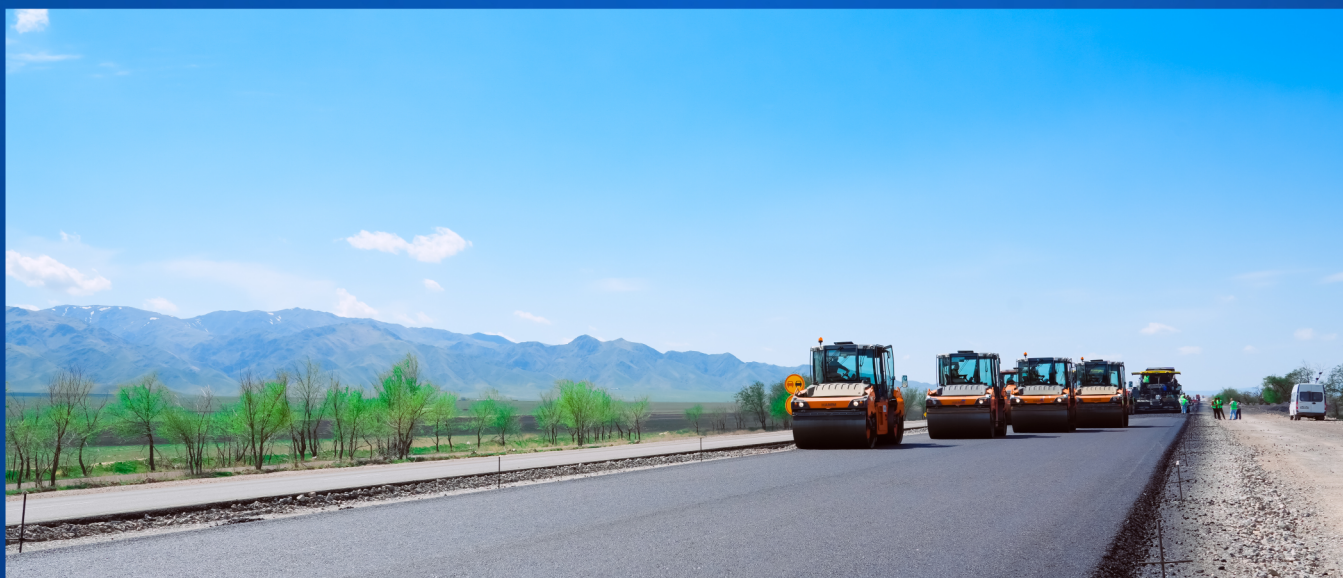
Участок автомобильной дороги «Узынагаш - Отар»
