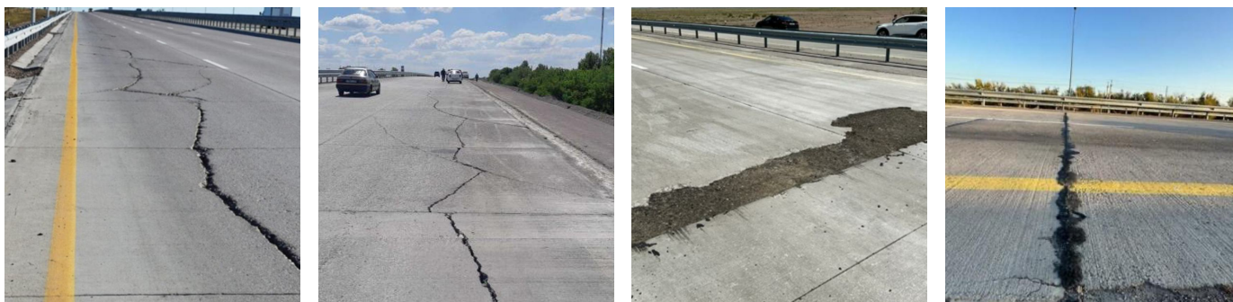
Рисунок 1 – Примеры дефектов на цементобетонных покрытиях
