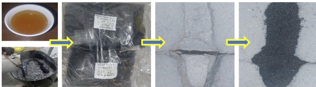
Рисунок 10 - Этапы приготовления асфальтобетонной смеси и результаты её применения
