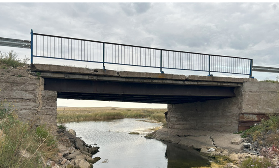
Мост через р. Нура на км 259+45 автодороги Р-3 «Нур-Султан-Кабанбай батыра-Энтузиаст-Киевка-Темиртау»
