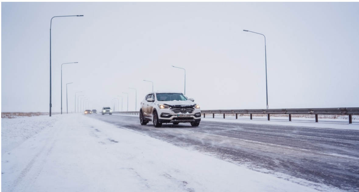
Автомобильная дорога «Екатеринбург-Алматы» в пределах Карагандинской области на объекте «Север города Темиртау перед транспортной развязкой Березняки» (км 1433,9-1434,4).
