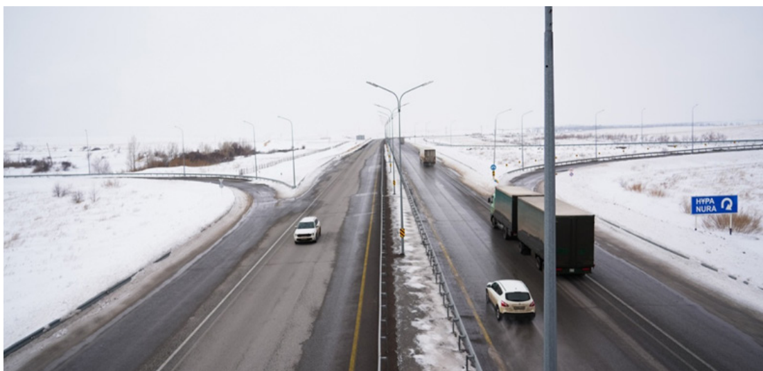
Автомобильная дорога «Екатеринбург-Алматы» в пределах Карагандинской области на объекте «Север города Темиртау перед транспортной развязкой Березняки» (км 1433,9-1434,4).
