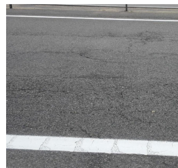
Рисунок 1 – Усталостные трещины на автомобильных дорогах М-1 и М-4
