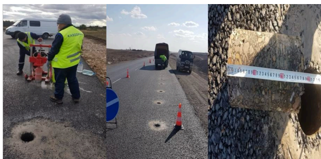
Рисунок 1 – Отбор кернов с участков обследуемых автомобильных дорог «Петропавловск-Курган» КМ 503, ПК 196+72,25 по ПК 197+30,25 и «Мерке-Бурылбайтал» (Обход г.Шу) КМ 90, ПК 24+26,75 по ПК 24+80,85.
