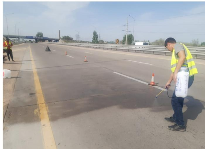
Рисунок 2 – Распыление пропиточным составом
