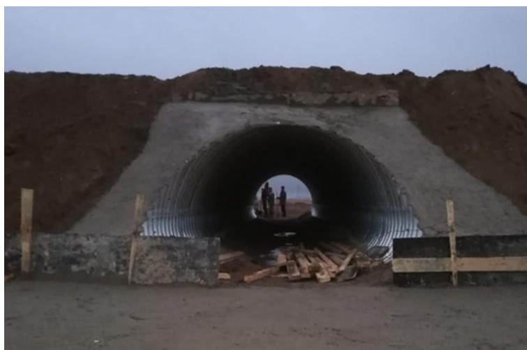
Рисунок 3 - Скотопрогон после усиления из МГК
