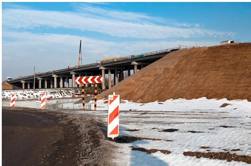
Рисунок 9 - Армированный откос и строящийся путепровод
